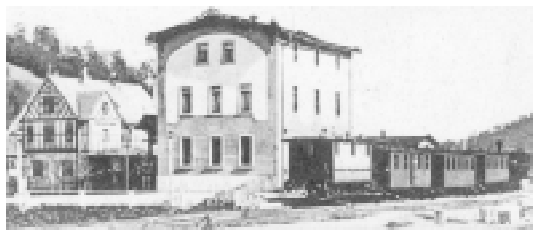
Das Empfangsgebäude im Zustand von 1906. [2]
